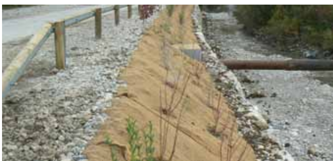
Haut de berge retaluté et planté d'arbustes, Serres, 2008.
