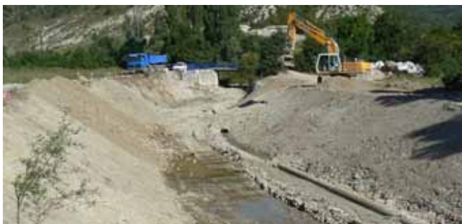
Travaux en cours sur le Céans, Laborel, 2008.
